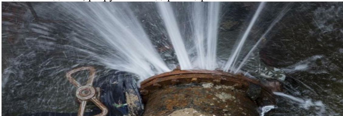
Рис. 1. Утечка из фланцевого соединения водопроводного трубопровода
